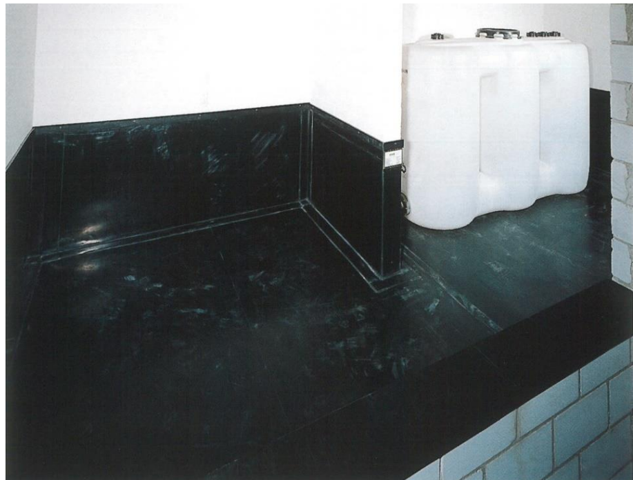
Auskleidung / Abdichtung eines Schutzbauwerks mit Platten aus Polyethylen hoher Dichte (PE-HD) zu Anlageteilen für wassergefährdende Flüssigkeiten, zertifiziert nach KVV
