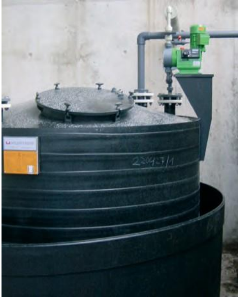
Chemikalienbehälter mit Auffangwanne und Dosierpumpe
