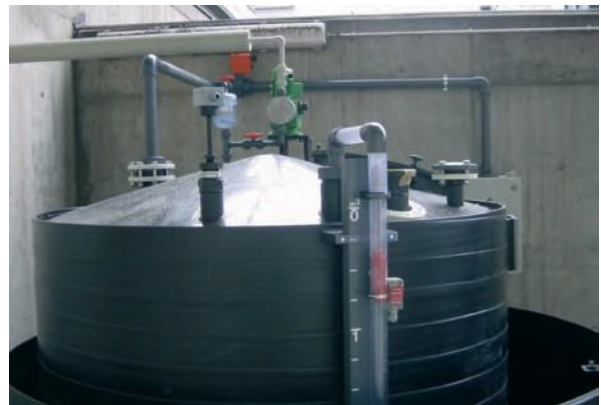
Chemikalienbehälter mit Auffangwanne und Dosierpumpe
