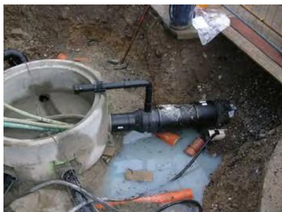
PE-Doppelrohrleitung im Grundwasserbereich für Liegenschaften-Entwässerung und evt. belastetes Oberflächenwasser von Strassenentwässerung
