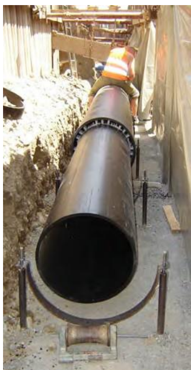
PE-Doppelrohrleitung im Grundwasserbereich für Liegenschaften-Entwässerung und evt. belastetes Oberflächenwasser von Strassenentwässerung
