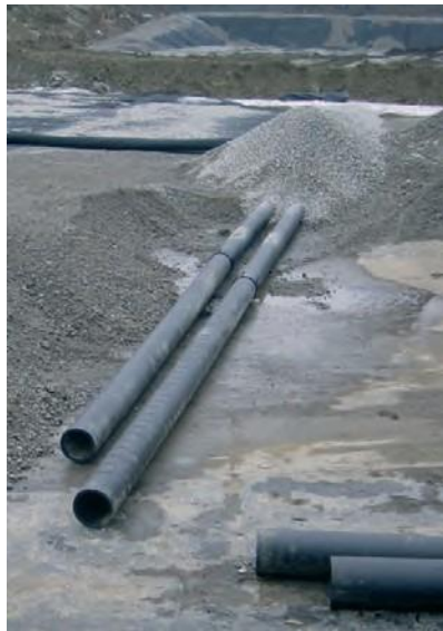
Sickerleitung unter Deponieabdichtung aus PE-HD-Rohren
