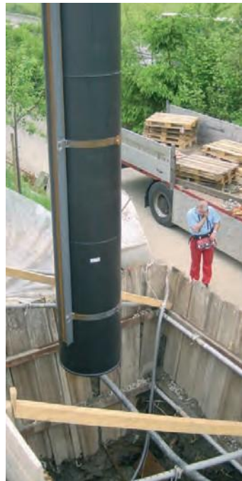
Ersatz eines 10 m tiefen Deponieschachtes
