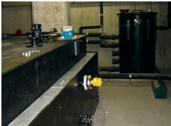
Badewasserbehälter aus PP vor Ort montiert
