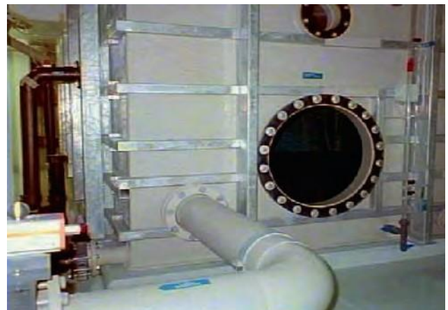
Behältereinbau mit div. Einzelteilen vor Ort in bestehender Anlage. Werkstoff PE-HD
