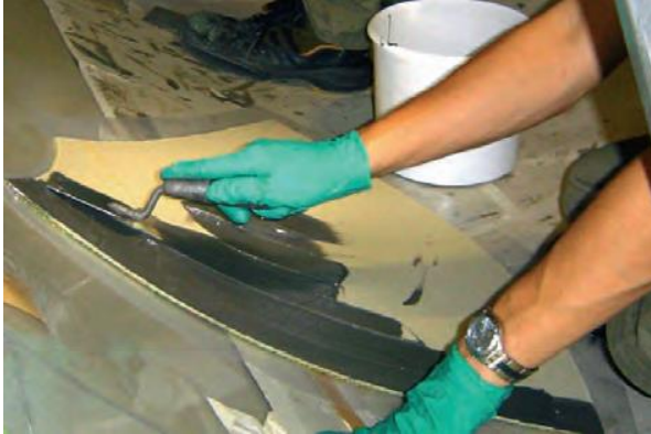
Ein masslich vorbereitetes und umgeformtes ECTFE-Segment wird zum Einsetzen vorbereitet.
