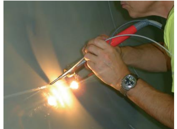
Dichtes zusammenschweissen unter Edelgas erfordert höchste Konzentration
